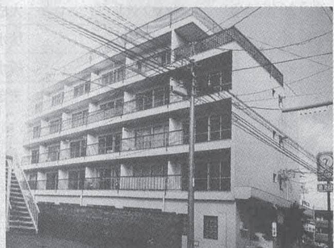
リファイニング工事の前(上)と後
