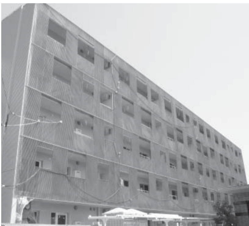
グレーチングを利用したスクリーンを設置
