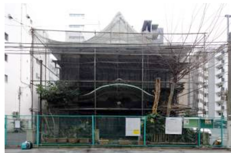
道路側からの工事着工前状況
