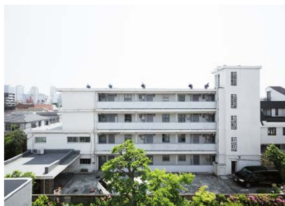
リファイニング前の外観
