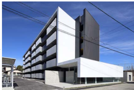
リファイニング後の外観
