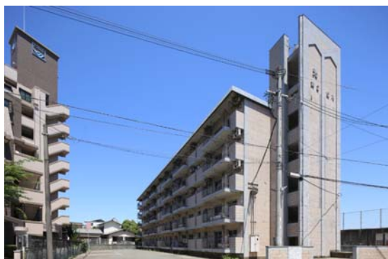
リファイニング前の外観
